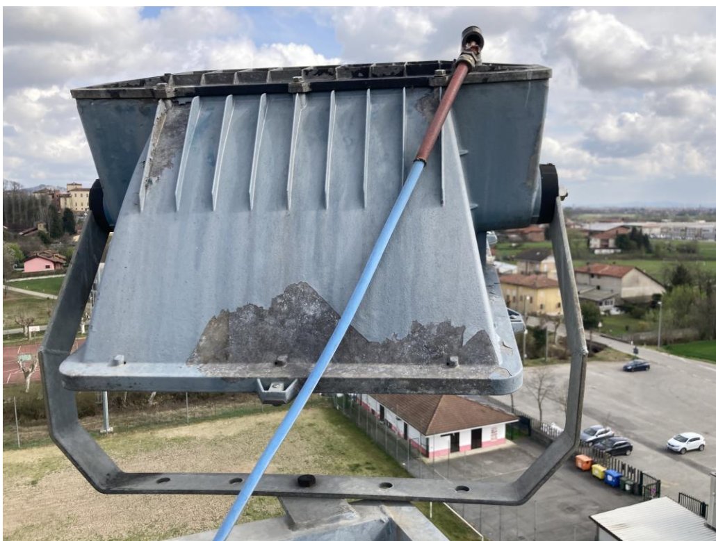
Figura 8: Vista di un dispositivo illuminante con cablaggio vetusto e ammalorato
