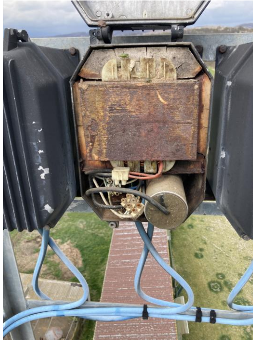
Figura 9: Sistema di allacciamento vetusto e ammalorato tempo ed esposizione ad agenti atmosferici
